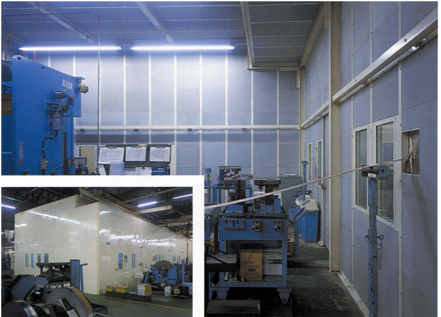
プレスライン用大型防音室（外観）
