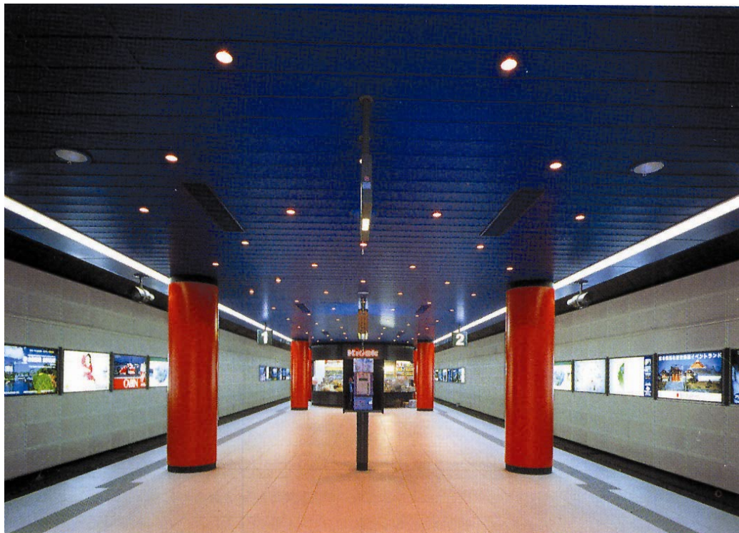
JR 新千歳空港ホーム両サイド吸音壁 (白い側壁部分にカルム採用)
