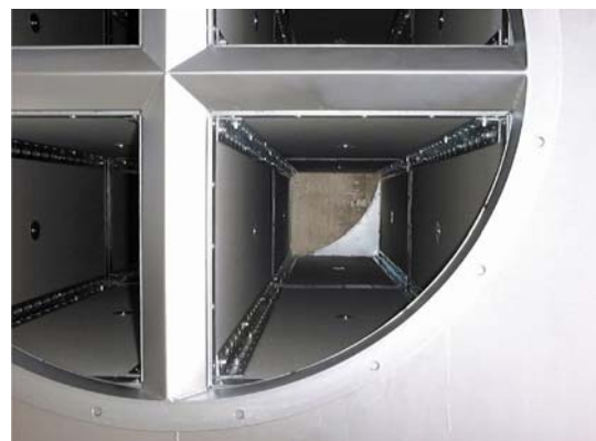
ユニットサイレンサー内部
