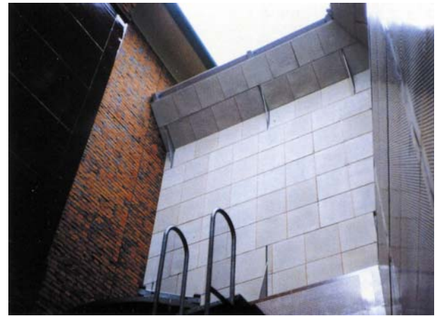
クリーニングタワー用防音壁 (効果-20dB)
